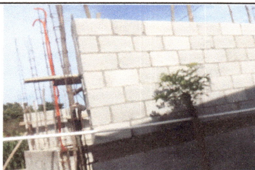
Foto 3: EN LA IMAGEN SE OBSERVA EL TRABAJO CON UN AVANCE DEL 80 POR CIENTO EN SEGUIMIENTO AL ANTERIOR
