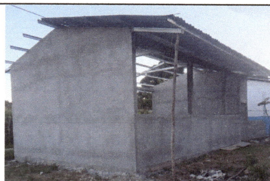
Foto 4: EL TECHADO DEL AULA CON UN AVANCE DEL 50 POR CIENTO DE INSTALACIÓN.
