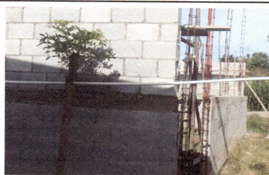
Foto 2: EL TRABAJO A UN 60 POR CIENTO DE AVANCE DE LA CONSTRUCCION DEL AULA
