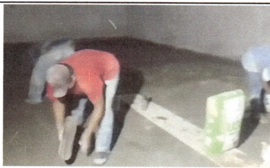
Foto 6: INSTALACION DEL PISO POR LOS TRABAJADORES ENCARGADOS LA LA CONSTRUCCION CON UN AVANCE FINAL
