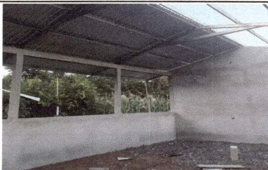
Foto 5: SE OBSERVA EN LA FOTOGRAFÍA LA INSTALACION DE TECHADO DEL AULA
